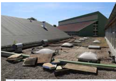
Évacuation de l'ancien complexe d'étanchéité
